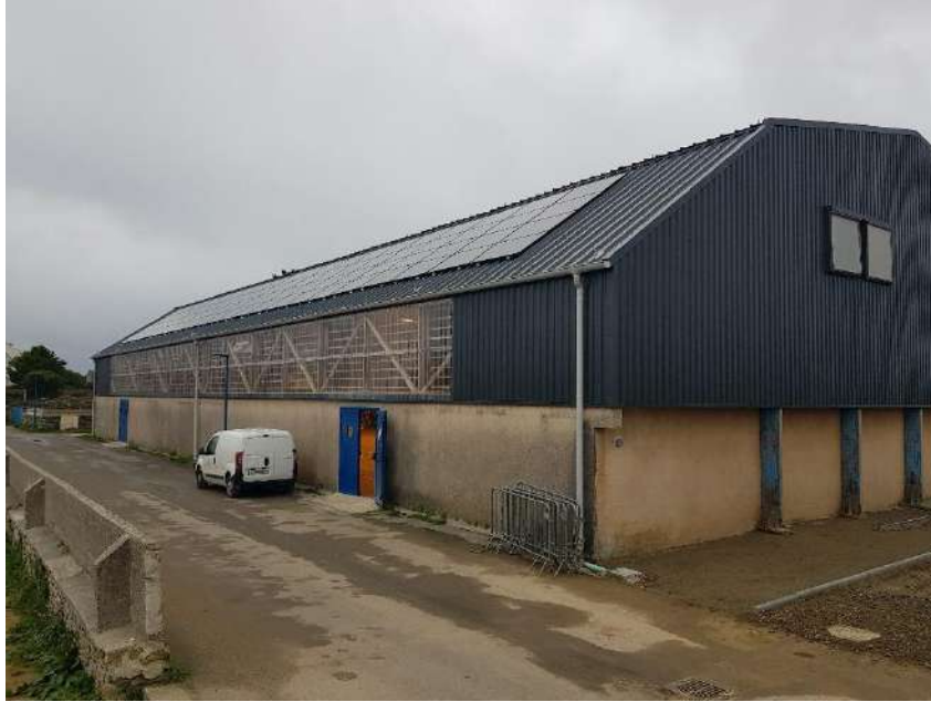
Figure 2.13 Le centre sportif d'Ouessant, avec la moitié inférieure de l'installation photovoltaïque.
