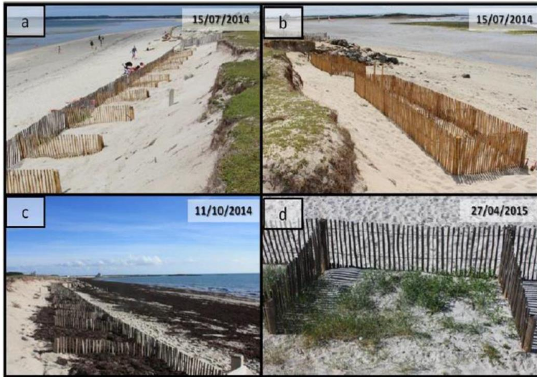
: Deux types AlgoBox® installés en juillet 2014 sur la plage de Penvins dans le Morbihan, France (a et b) ; échouage massif d'algues rouges et remplissage des AlgoBox® avec S. chordalis (c) ; colonisation des AlgoBox® par la végétation (d) (Sedrati et Cochet 2015).
